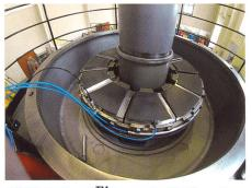
Bild 3. Polypad  $^{TM}$ -Lager im Kraftwerk Rempen.
