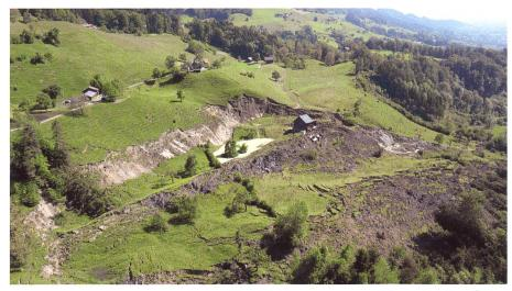
Bild 8. Am 4. Juni rutschten im Gebiet Ober Weidist in Altstätten SG rund 1 Mio. m<sup>3</sup> Erdmasse talwärts. Ein Stall wurde beschädigt und tiefe Risse zeigten sich in der Weide (Foto: Tiefbauamt Kanton SG).
