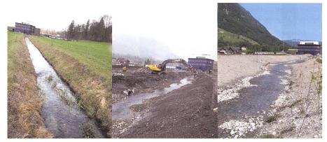
Bild 3. Abschnitt A vor (links), während (Mitte) und nach (rechts) den Revitalisierungsbauarbeiten.
