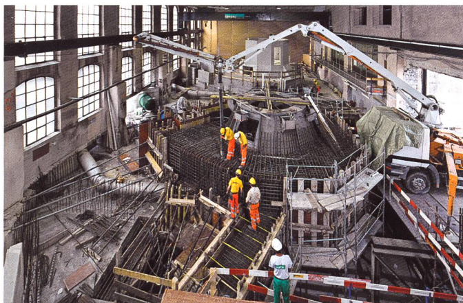
Figure 8. Phase 2 des travaux: construction des groupes n°1 et n°2; turbine Pelton; photo: M. Martinez.
