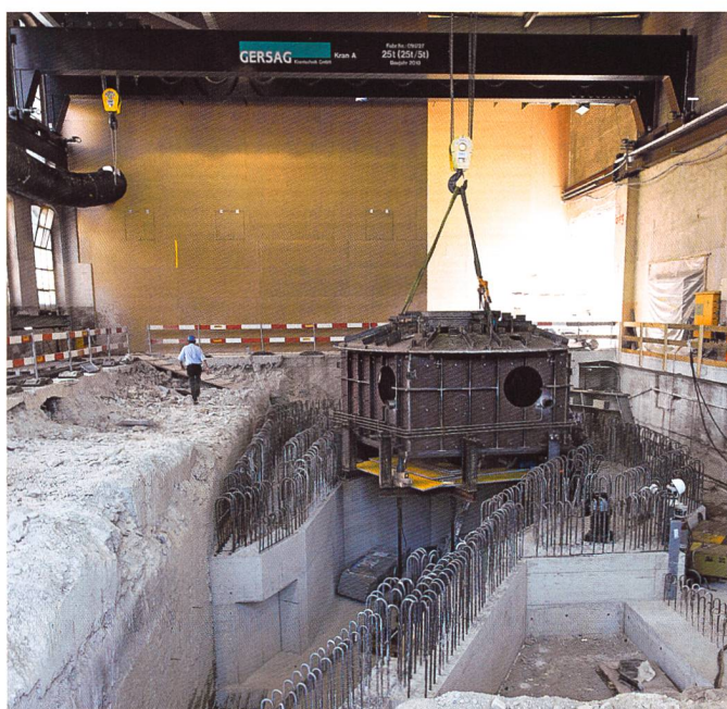
Figure 7. Phase 1 des travaux: Installation des nouveaux ponts roulants et construction du groupe n°3.
