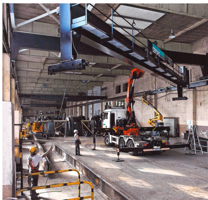
Figure 7. Phase 1 des travaux: Installation des nouveaux ponts roulants et construction du groupe n°3.
