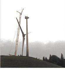
Bild 1. Montage der Rotorblätter und Nabe (Foto: CKW).
