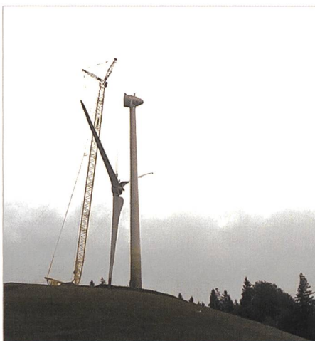
Bild 1. Montage der Rotorblätter und Nabe (Foto: CKW).
