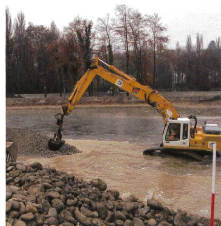
Bild. Lokale Ufersicherung mit Blöcken (Foto: zvg).
