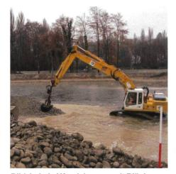
Bild. Lokale Ufersicherung mit Blöcken (Foto: zvg).
