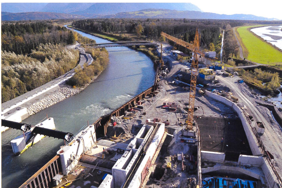
Bild 9. Luftbild zum Bau von seitlichem Entnahmebauwerk und Maschinenhaus (Ansicht flussaufwärts), Okt. 2013.
