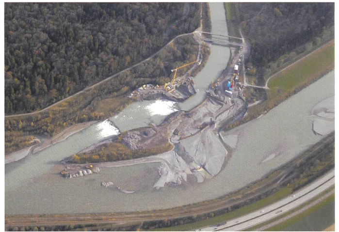
Bild 6. Luftbild während Bau der Wehrfelder, unmittelbar nach dem Oktober-Hochwasser, Nov. 2012.
