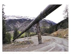
Bild 2. Die Druckleitung wird neu und mit fast doppeltem Durchmesser in die Erde verlegt (Quelle: Südostschweiz).
