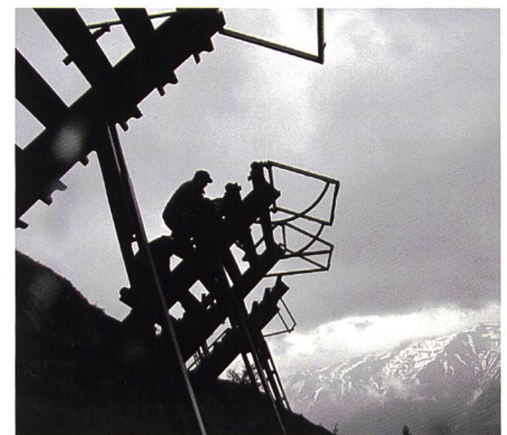
Bild 8. Pilot-Einzel Montage der Solarmodulrahmen, (Quelle: Graf, 2012).
