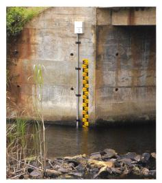
Bild 3. Neu errichtete Abflussmessstation am Fluss Kamwana.
