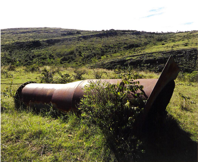
Bild 9. Einlaufrohr des Vorgängerprojektes.
