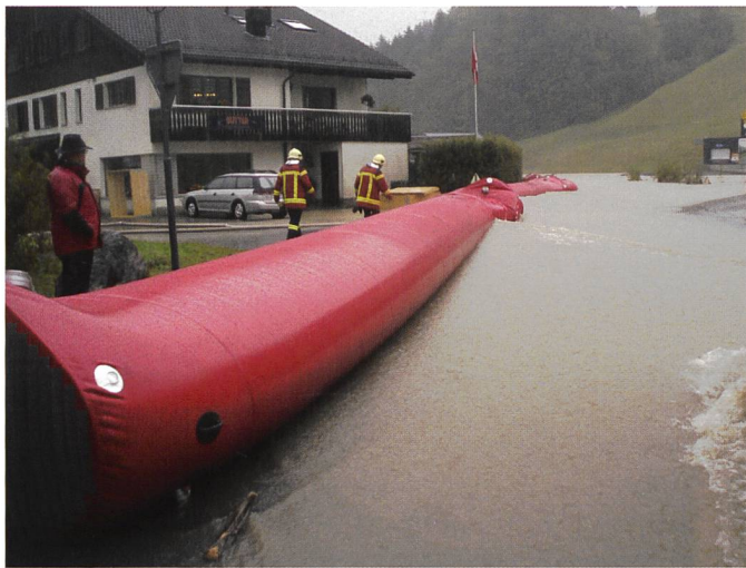
Bild 13. Hochwasserschutzschläuche in Alt St. Johann.
