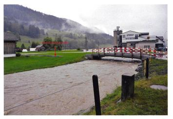
Bild 12. Ausgebautes Gerinne der Säntisthur mit der neu erstellten Brücke Langhans. Die Entlastung entlang des linken Ufers ist 2011 nicht angesprungen.
