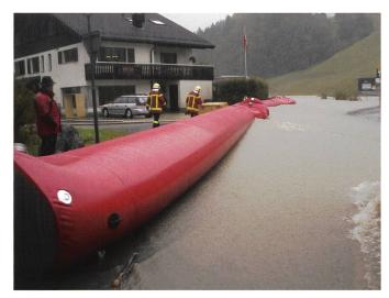
Bild 13. Hochwasserschutzschläuche in Alt St. Johann.
