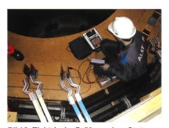
Bild 2. Elektrische Prüfung einer Statorwicklung.
