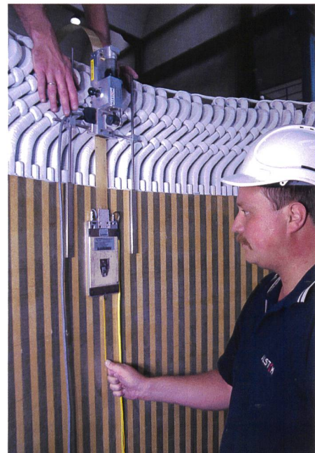
Bild 1: Nutverkeil-Kontrolle mit Roboter.
