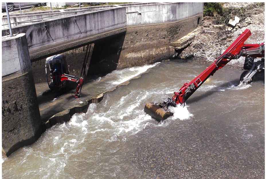
Bild 1. Geschiebebaggerungen an einer Wasserfassung eines Niederdruckkraftwerks im Mittelland bei abgesenkter Stauhaltung.
