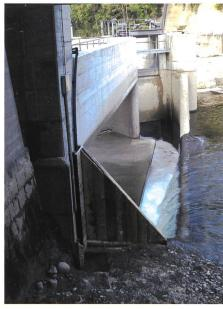
Bild 3. Trennschwelle mit anschliessender Geschiebesammel- und -spülrinne und Grazer Kragschwelle an der Wasserfassung Mühlau bei abgesenkter Stauhaltung.
