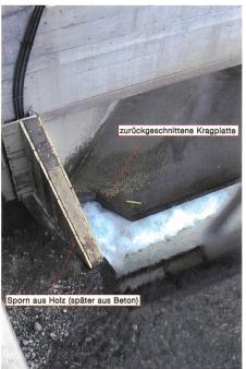
Bild 10. Zusätzliche Massnahmen zur Geschiebeabwehr an der Fassung: a) Zurückschneiden der Kragschwelle und b) Sporn aus Holz.
