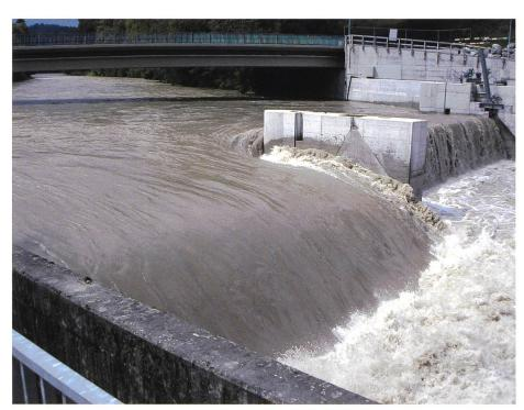
Bild 12. Geschiebeabweisung durch unsymmetrische Klappenöffnung bei Thur-Abflüssen bis ca.  $250 \, \text{m}^3/\text{s}$ .
