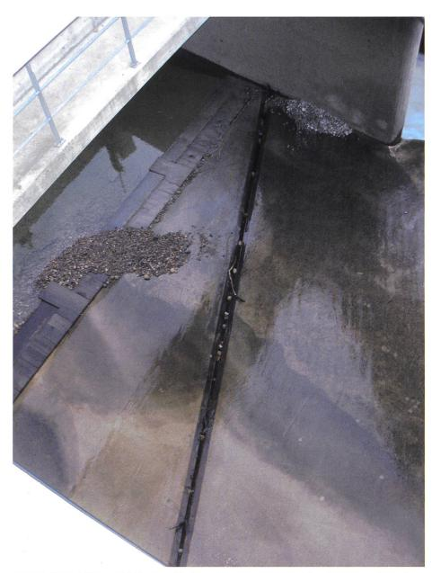
Bild 16. Wirbelröhre mit teilweiser Verklausung des 60 mm breiten Schlitzes, links die Geophone der zweiten Reihe.
