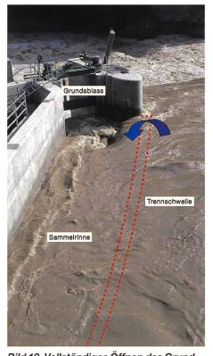
Bild 13. Vollständiges Öffnen des Grundablasses wegen Schwemmholzproblemen erzeugt – trotz markantem Anstieg der Trennschwelle zum Pfeiler hin – vor allem eine starke Strömung in Schützennähe und entsprechend hohem Geschiebeeinzug, was durch die Impulszunahme auf den dortigen Geophonen nachgewiesen werden konnte.
