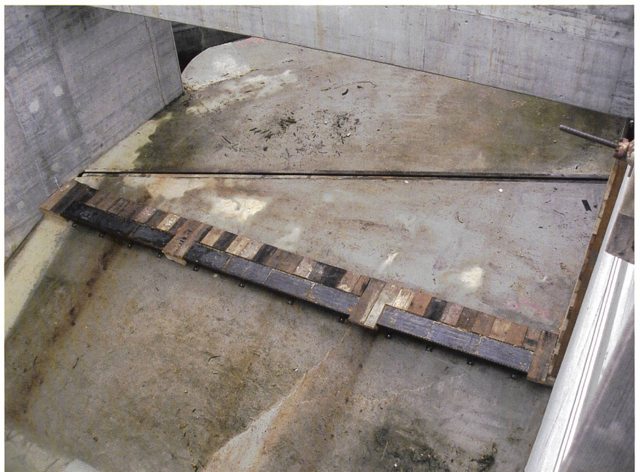
Bild 5. Zweite Geophon-Plattenreihe mit Holzverschalung nach der Wirbelröhre (Schlitz in Einlaufsohle) kurz nach der Montage.
