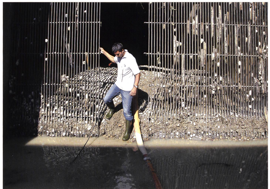
Bild 8. Vorgefundene Ablagerungen hinter dem Rechen, nachdem die Stauhaltung Ende September 2011 aufgegeben und die gesamte Wasserfassung sowie die Turbineneinläufe entwässert worden waren.
