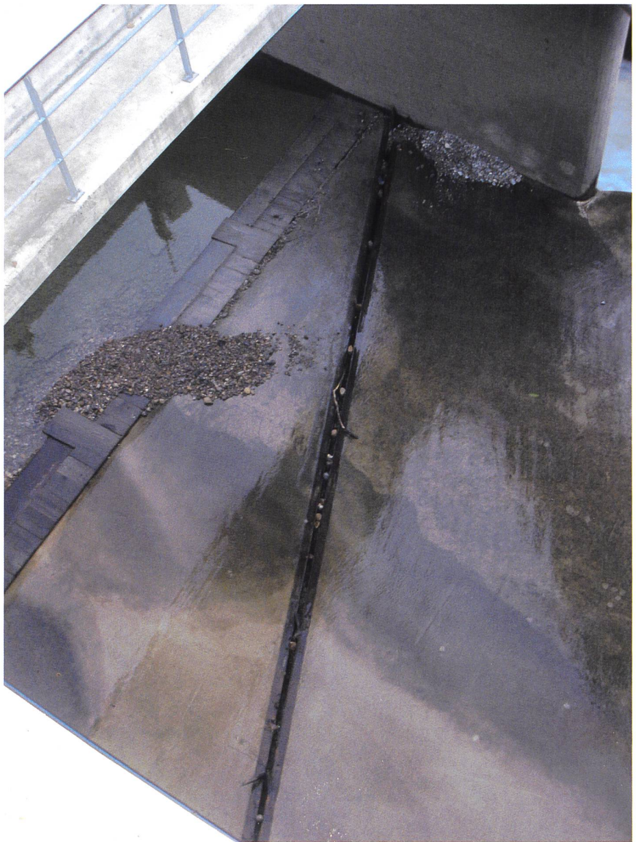
Bild 16. Wirbelröhre mit teilweiser Verklauung des 60 mm breiten Schlitzes, links die Geophone der zweiten Reihe.
