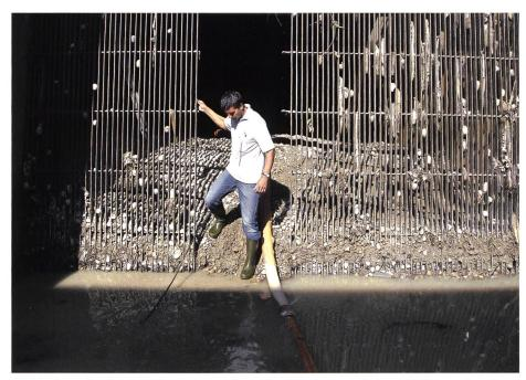
Bild 8. Vorgefundene Ablagerungen hinter dem Rechen, nachdem die Stauhaltung Ende September 2011 aufgegeben und die gesamte Wasserfassung sowie die Turbineneinläufe entwässert worden waren.
