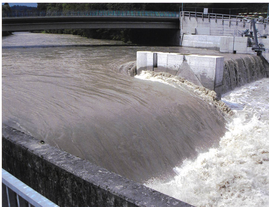
Bild 12. Geschiebeabweisung durch unsymmetrische Klappenöffnung bei Thur-Abflüssen bis ca. 250 m 3 /s.
