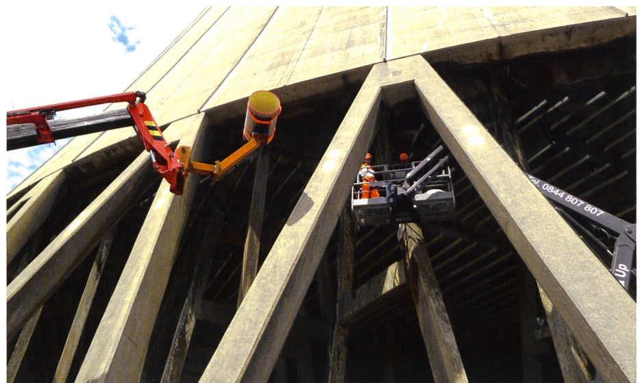
Bild 2. Ersatz der defekten Rohrverbindungen.
