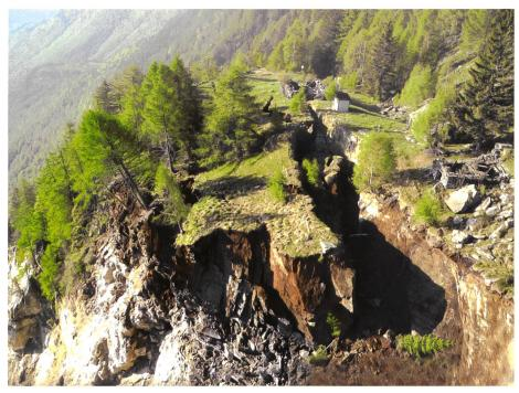
Bild 6. Weitere Gesteinsmassen drohten nach dem Felssturz am 15. Mai in Preonzo TI abzubrechen (Foto: Cantone Ticino, Divisione delle costruzioni).
