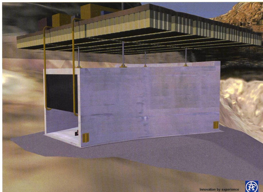
Bild 3. Fassungsbauwerk auf der Plattform 1917 m ü.M., kurz vor dem Transport in Richtung definitiven Standort (Animation: AFC).
