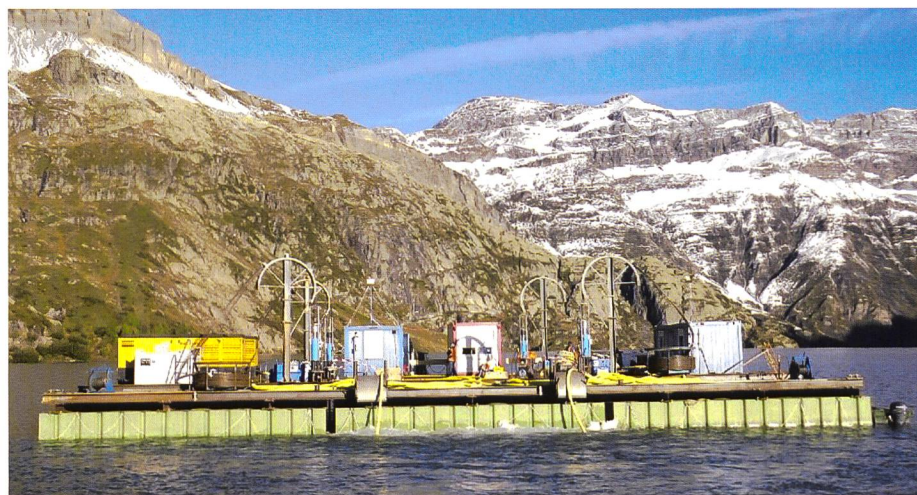
Bild 4. Die Pontons beim Transport des Fassungsbauwerkes an den Bestimmungsort, angetrieben von einfachen Aussenbordmotoren. Die grauen Stahlgerüste sorgten für den Seilnachschub und die Seilführung; links sind die gelben Luftkompressoren zu erkennen (Foto: Ndd).
