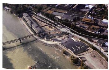
Bild 13. Vor dem Rückbau des alten Kraftwerks musste ein Fangedamm und ein Sortierplatz für die Abbruchmaterialien erstellt werden.
