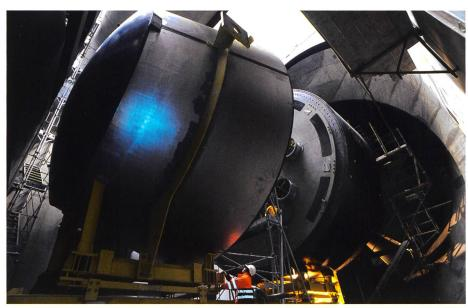
Bild 10. Zusammenschieben des Generatorstators über den Rotor.
