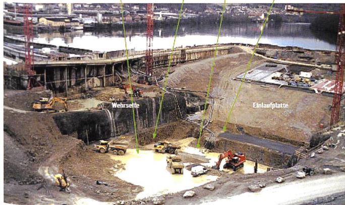
Bild 3. Schematische Lage des Maschinenhauses in der Baugrube.
