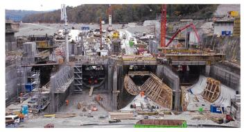
Bild 5. Unterwasserauslauf Saugrohrstrukturen Maschinen 1-4.
