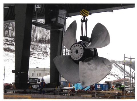
Bild 9. Einheben des ersten Turbinenlaufrades.
