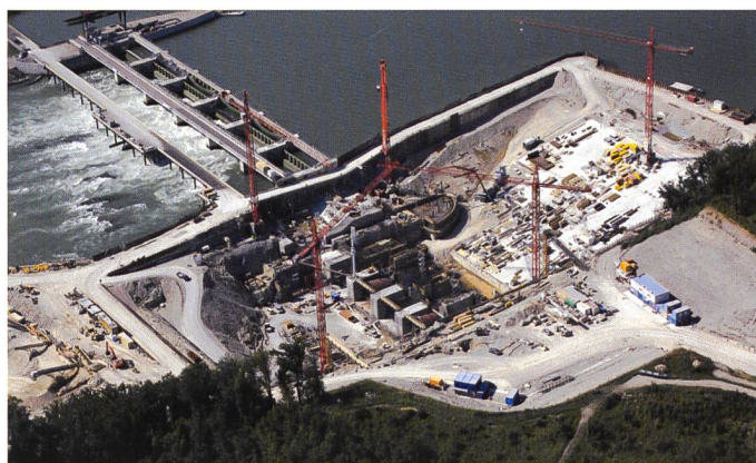
Bild 4. Baugrube Maschinenhaus.
