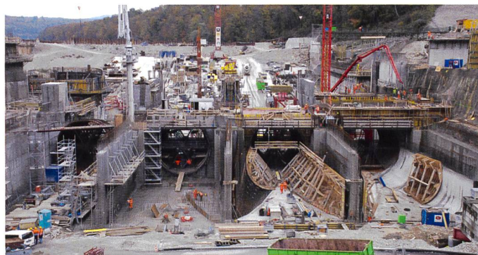
Bild 5. Unterwasserauslauf Saugrohrstrukturen Maschinen 1–4.
