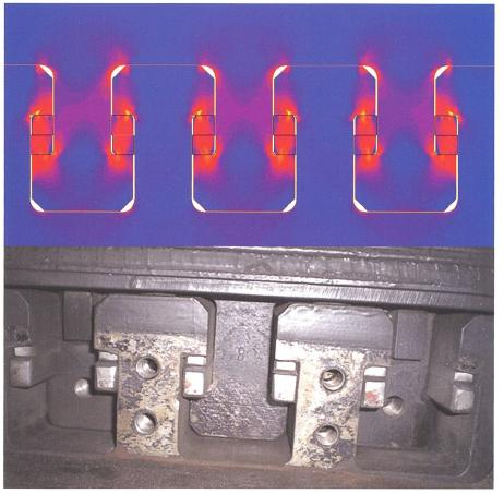
Bild 4. Revision Generatorenhammerköpfe eines Pumpspeicherkraftwerks.
