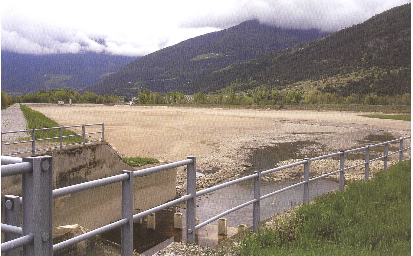
Bild 3. Bestehendes Ausgleichsbecken im Vinschgau, Südtirol – das sich prinzipiell auch für eine Schwall/Sunk-Dämpfung eignen würde. Das Becken hat ein Volumen von 400 000 m 3 .
