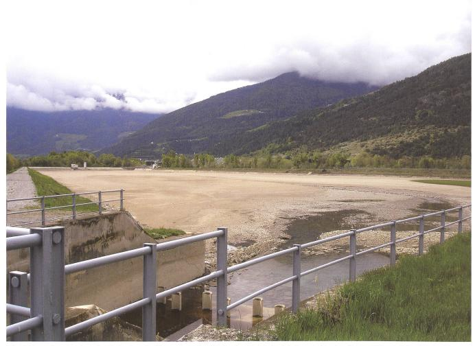
Bild 3. Bestehendes Ausgleichsbecken im Vinschgau, Südtirol – das sich prinzipiell auch für eine Schwall/Sunk-Dämpfung eignen würde. Das Becken hat ein Volumen von 400000 m³.
