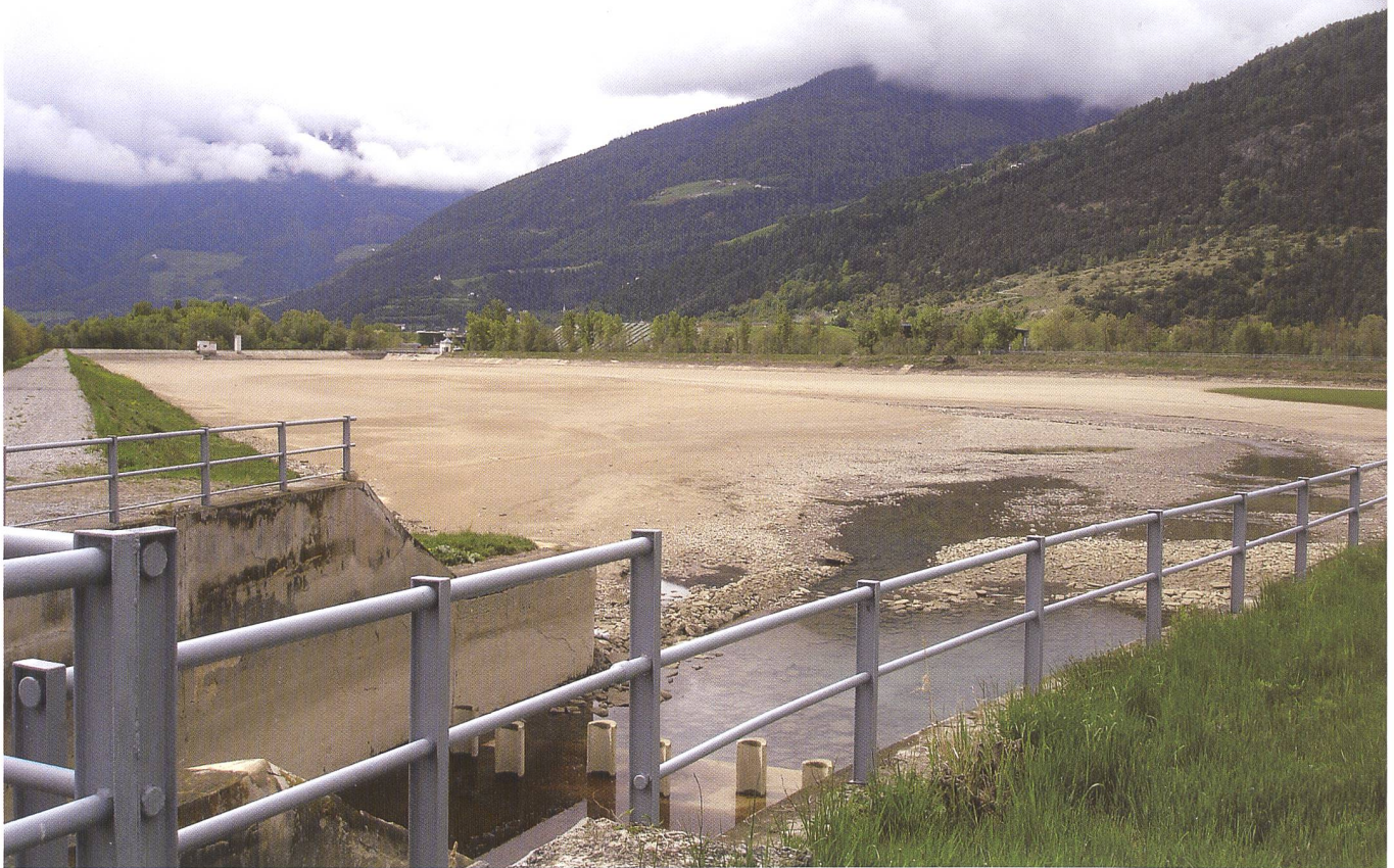
Bild 3. Bestehendes Ausgleichsbecken im Vinschgau, Südtirol – das sich prinzipiell auch für eine Schwall/Sunk-Dämpfung eignen würde. Das Becken hat ein Volumen von 400 000 m 3 .
