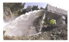
Bild 4. Demonstration des Auslaufbauwerks mit 20 m³/s, maximal sind 170 m³/s möglich. (Bild: Jano Felice Pajarola)
