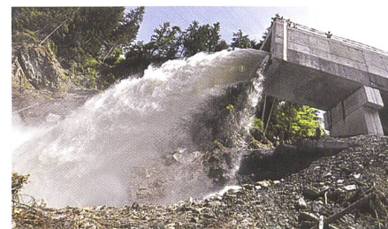
Bild 4. Demonstration des Auslaufbauwerks mit 20 m 3 /s, maximal sind 170 m 3 /s möglich. (Bild: Jano Felice Pajarola)
