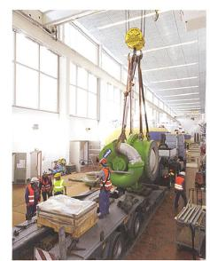
Bild 2. Viele Hände helfen mit, einen Kugelschieber in der Zentrale Sils zu entladen.
