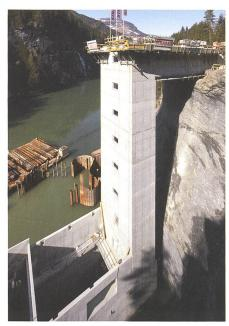
Bild 3. Einlaufbauwerk zum Umleitstollen (EWZ).
