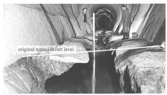
Bild 7. Erosion eines Bypass-Kanals. (Quelle: VAW).
