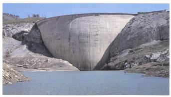
Bild 8. Durch den Bau eines Sondierstollens hat sich eine Verformung der Zeuzier-Staumauer ergeben, so dass zunächst eine Wasserabsenkung und anschliessend Injektionen erforderlich waren. (Quelle: www.swissdams.ch)
