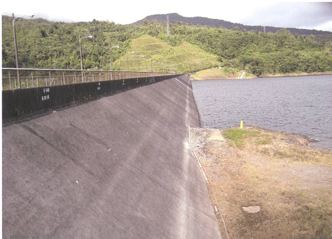
Bild 18. Fortuna-Damm: Erhöhter Teil mit Spritzbetonoberfläche.
