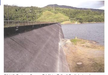
Bild 18. Fortuna-Damm: Erhöhter Teil mit Spritzbetonoberfläche.
