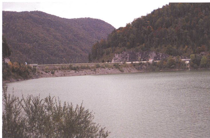
Bild 6. Sylvenstein-Damm mit Speichersee. Die steile Wand am rechten Widerlager ist gut erkennbar.
