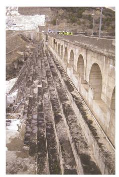
Bild 13. Yesa-Damm: Luftseite der bestehenden Schwergewichtsmauer.
