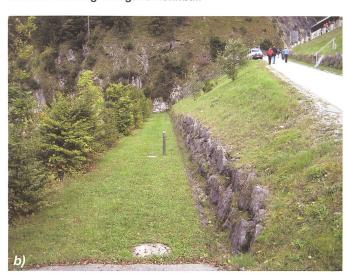
Bild 7. Sylvenstein-Damm: (a) Ansicht Luftseite, (b) Baumplanzungen im unteren Teil der luftseitigen Böschung.
