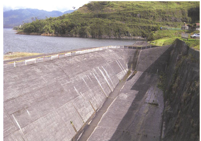
Bild 19. Fortuna-Damm: Neue Hochwasserentlastung am linken Ufer.
