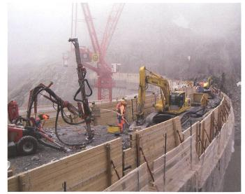
Figure 11. Démolition de la partie supérieure du premier barrage.
