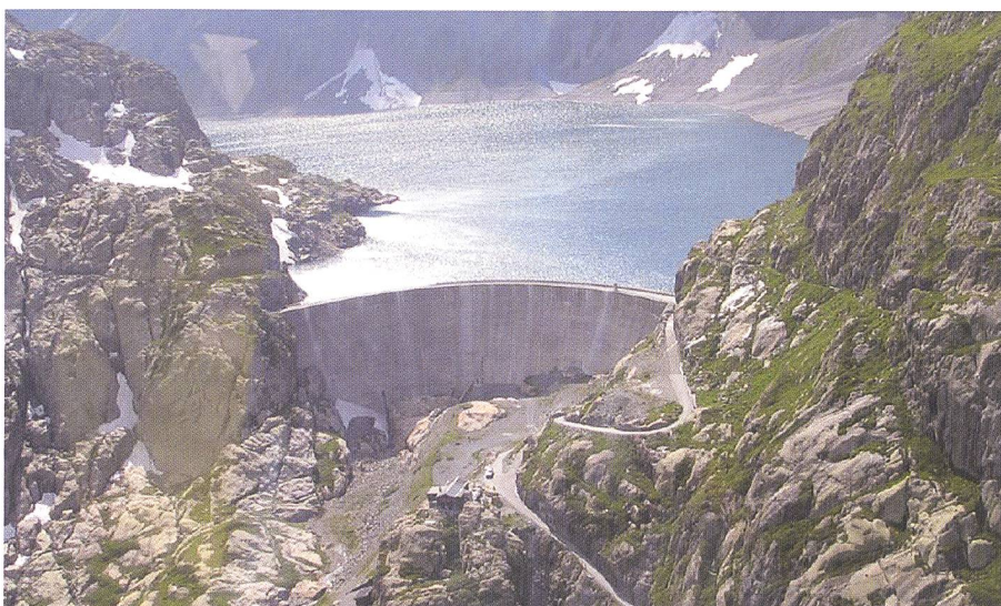
Figure 5. Vue aérienne du barrage du Vieux Emosson.
