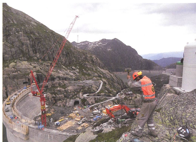
Figure 12. Vue générale du chantier.
