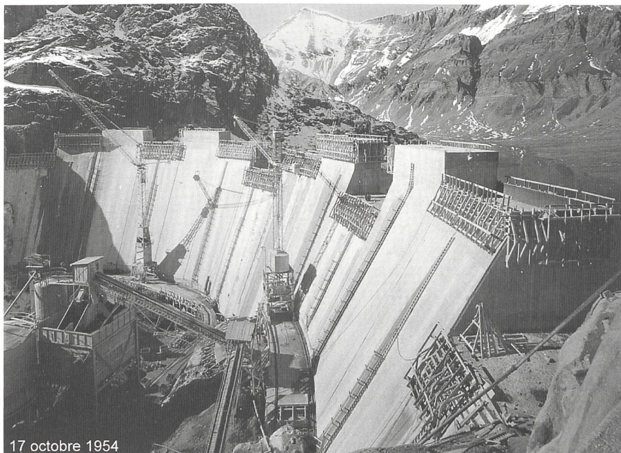
Figure 8. Photographie de la construction du barrage.
