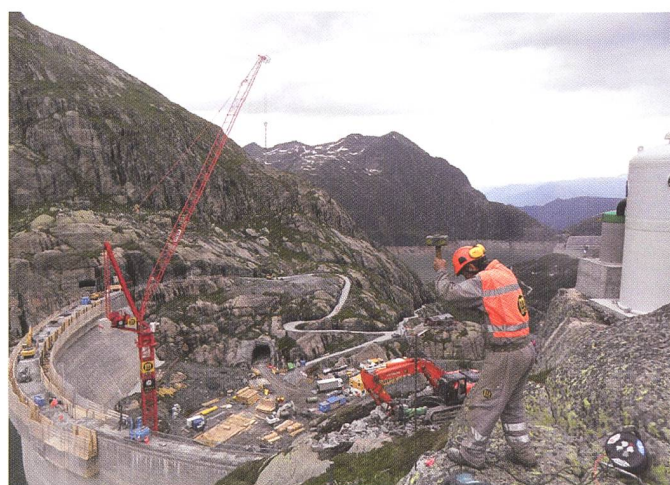
Figure 12. Vue générale du chantier.
