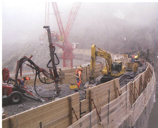
Figure 11. Démolition de la partie supérieure du premier barrage.
