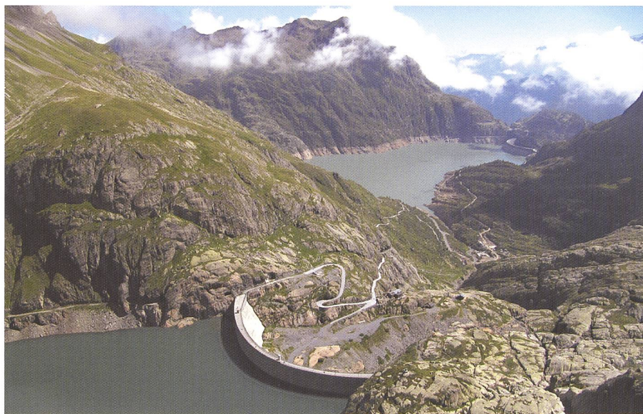
Figure 1. Les deux retenues de l'aménagement de Nant de Drance, au premier plan Vieux Emosson, au second Emosson.
