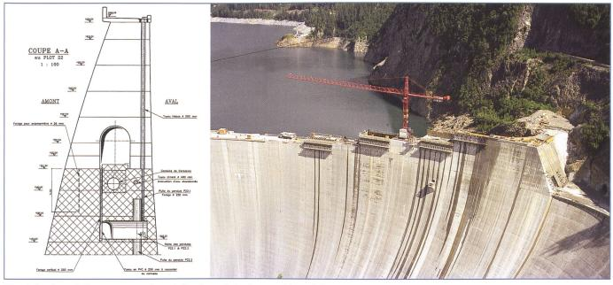
Fig. 4. Sezione della parte superiore della diga e foto durante i lavori di getto.
