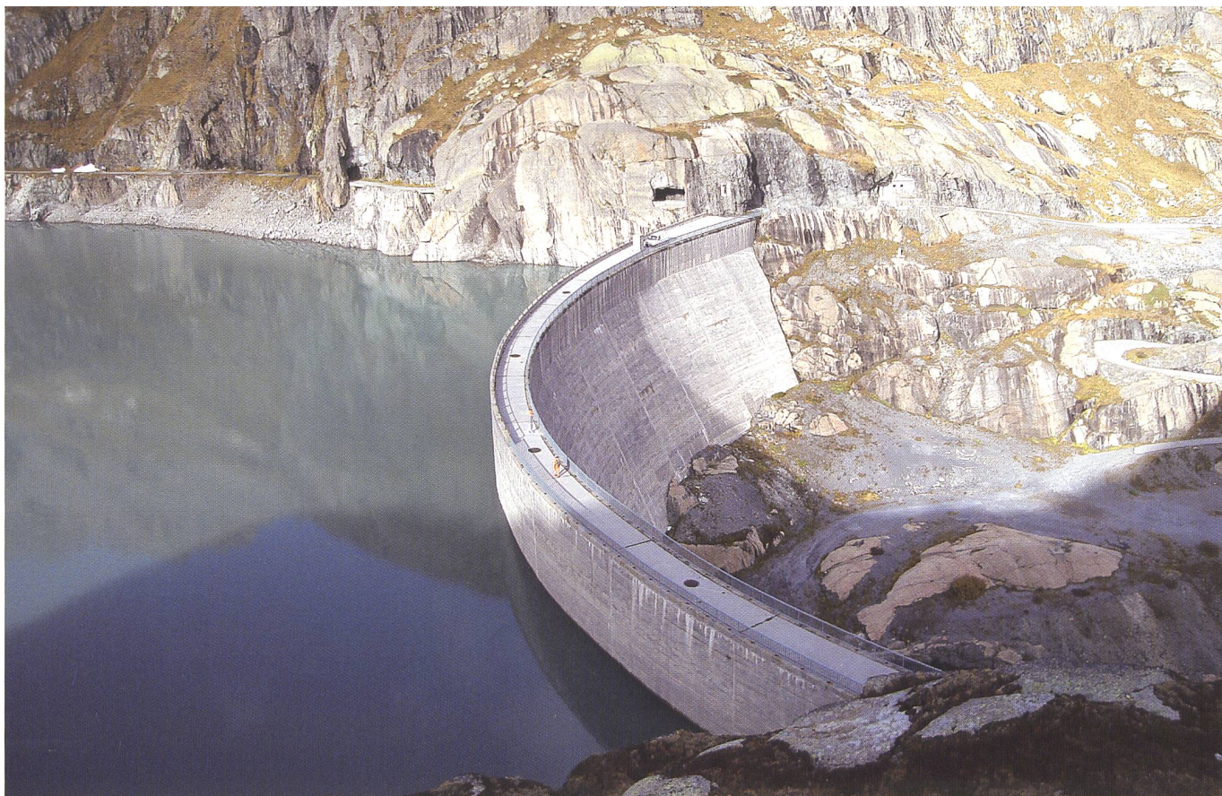
Bild 7. Erhöhung der Bogengewichtsmauer Vieux Emosson um 21.5 m zur Vergrößerung des Oberbeckens des Pumpspeicherwerkes Nant de Drance um 15 Mio. m 3 (Baubeginn Sommer 2012) (Photo Straub AG).
