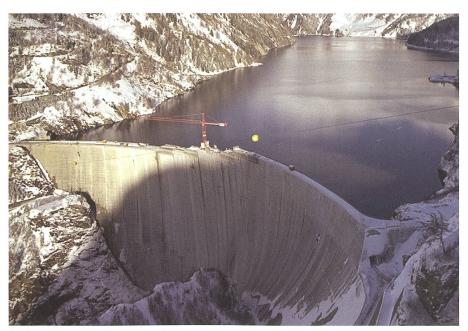
Bild 5. Bogenmauer Luzzone: Erhöhung um 17 m auf 225 m zwischen 1995 und 1999 mit Vergrösserung des Stauseevolumens um 20 Mio. m³, gleichbedeutend mit einer zusätzlichen Winterenergieproduktion von 60 GWh (Photo Maggia).
