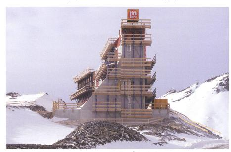
Bild 6. Vergrösserung des Muttsees um 15 Mio. m³ durch eine neue, bis zu 35 m hohe Gewichtsmauer.
