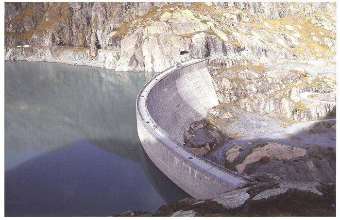
Bild 7. Erhöhung der Bogengewichtsmauer Vieux Emosson um 21.5 m zur Vergrösserung des Oberbeckens des Pumpspeicherwerkes Nant de Drance um 15 Mio. m³ (Baubeginn Sommer 2012) (Photo Straub AG).
