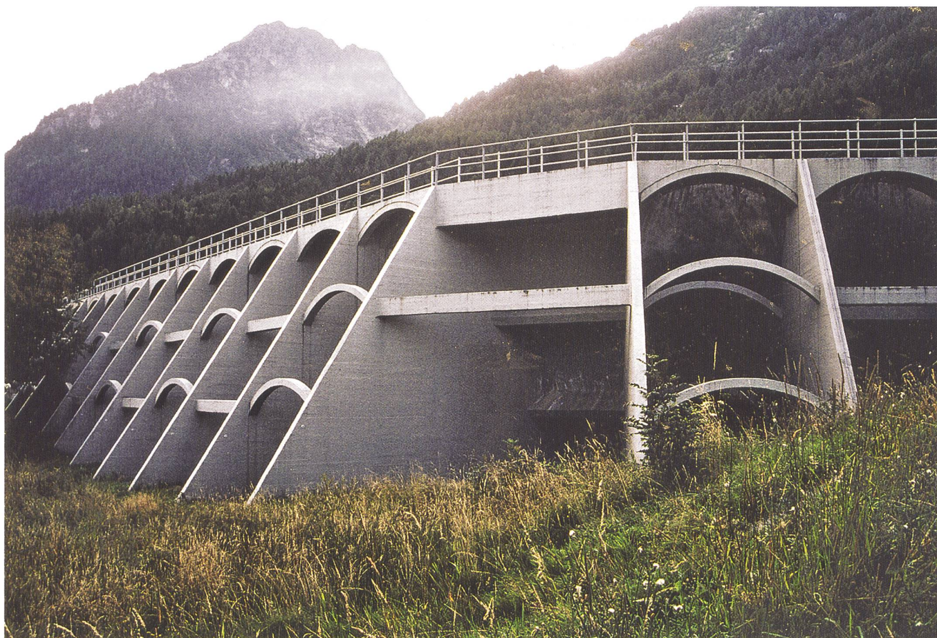
Bild 6. Zu den hervorragenden Staumauerkonstruktionen gehört diejenige von Marécottes. Sie entstand 1925 in einer sparsamen Eisenbetonbauweise mit Streben und Vielfachbögen, Foto HB 1989.
