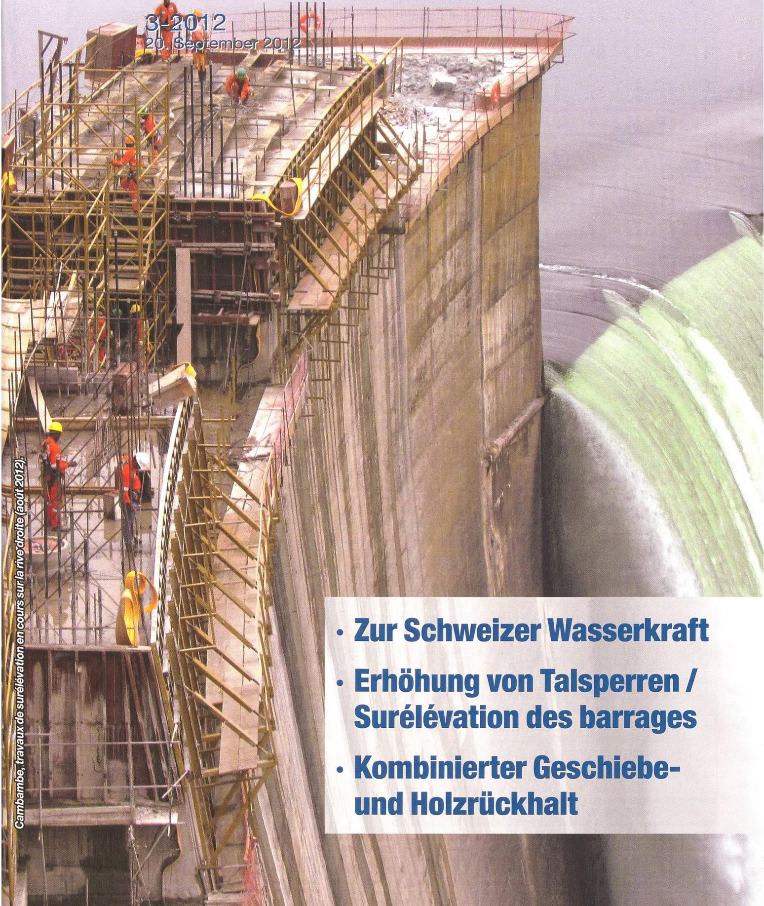
Cambambe, travaux de surélévation en cours sur la rive droite (août 2012).
