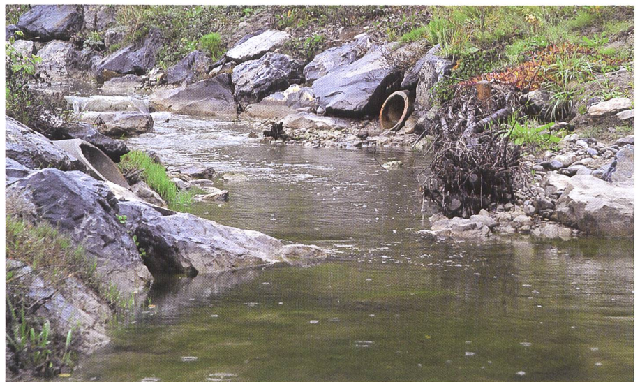
Bild 5. Bachstrecke Hell-Gamlikon, Drainageeinleitungen ohne Auflandungen.
