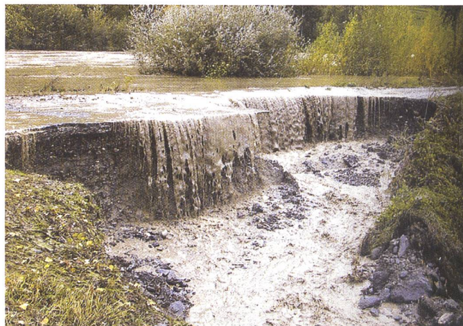
Bild 3. Dammbbruch bei Bieudron VS an der Rhone während des Hochwassers vom 15. Oktober 2000 (Aufnahme Grande Dixence SA).
