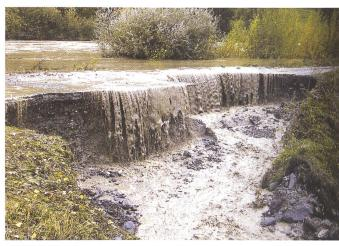
Bild 3. Dammbruch bei Bieudron VS an der Rhone während des Hochwassers vom 15. Oktober 2000 (Aufnahme Grande Dixence SA).
