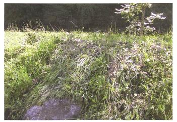
Bild 2. Hochwasserschutzdamm der Lütschine unterhalb von Wilderswil nach dem Hochwasser von August 2005. Der Damm wurde leicht überströmt, der Grasbewuchs hat die Böschung (noch) vor Erosion geschützt.
