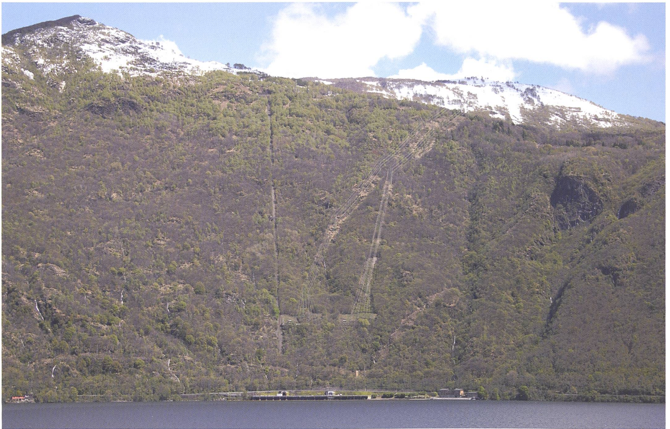
Bild 5. Pumpspeicher-Kraftwerk Ronco Valgrande und Monte Borgna am Ostufer des Lago Maggiore mit den Eingängen zur Kavernenzentrale, der Werkbahn zum Stausee und den Hochspannungsleitungen 380 kV (Foto G. Egger).
