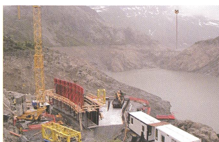
Bild 1. Fertigung des Ein-/Auslaufbauwerkes am Ufer (Foto: SWV/Pfa).
