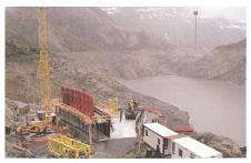
Bild 1. Fertigung des Ein-/Auslaufbauwerkes am Ufer (Foto: SWV/Pfa).
