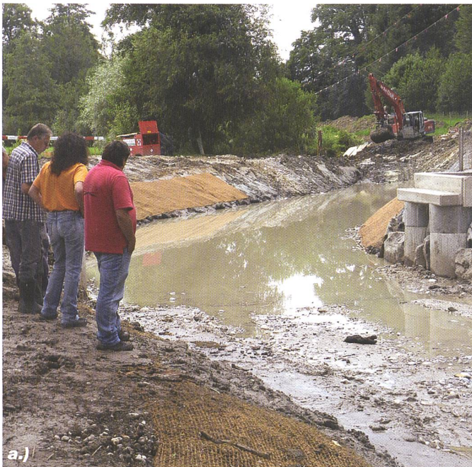
Bild 6a und 6b. Einbau eines Hanggitters im Rahmen einer Renaturierung an der Önz in der Gemeinde Graben (BE), (Bild: Peter Lakerveld).
