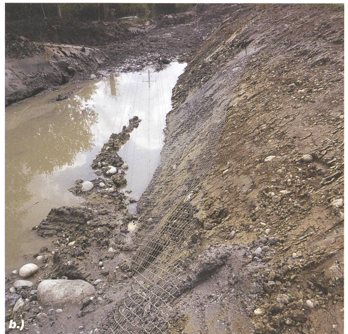
Bild 6a und 6b. Einbau eines Hanggitters im Rahmen einer Renaturierung an der Önz in der Gemeinde Graben (BE), (Bild: Peter Lakerveld).
