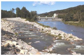
Bild 3. Wasserkraftanlagen haben strenge Umweltauflagen zu erfüllen (Bild: Umgehungsgewässer für die Fischwanderung beim Kraftwerk Rupperswil an der Aare; Foto: SWV/mmi).
