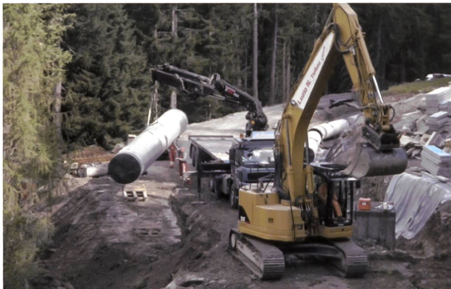
Bild 2. Einbringen der druckfesten Stahlleitung (Quelle: ewz)
