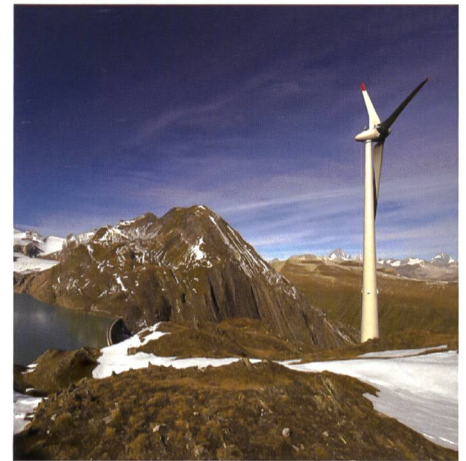
Bild. Die höchstgelegene Windenergie Europas steht am Gries im Wallis auf 2465 m ü.M. Dieser Standort in der Nähe des gleichnamigen Staudammes wurde gewählt, um die Windturbine mit den vorhandenen elektrischen Leitung verbinden zu können (Quelle: SwissWinds AG).
