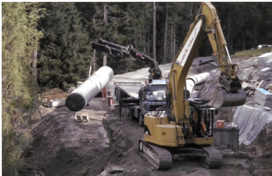
Bild 2. Einbringen der druckfesten Stahlleitung (Quelle: ewz)
