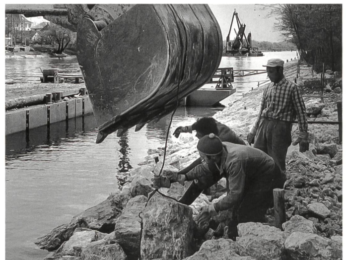
Bild 9. Steinwüste oder Uferschutz: Uferausbau während der Zweiten Juragewässerkorrektion. (archiv suzanne muller).
