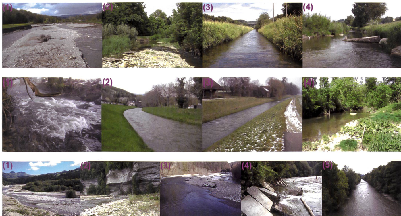
Bild 3. Aufnahmen der Untersuchungsabschnitte. Bünz (oben): (1) durch Jahrhunderthochwasser 1999 geformtes pendelndes System («Bünzaue»), (2) naturbelassen pendelnd, (3) kanalisiert, (4) revitalisiert.
