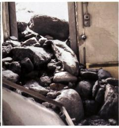
Bild 2. Beschädigte Wasserfassung Riedbach in Grächen (Mattertal, Mattmark AG) als Folge eines Wasserausbruches im Riedgletscher am 08. August 1989 (Fotos: Kraftwerke Mattmark AG).
