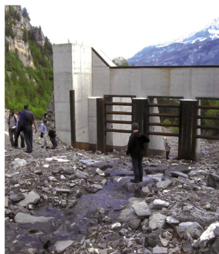
Ausleitbauwerk und Geschieberückhalt. Hochwasserschutzmassnahmen am Glyssibach, Schwanden bei Brienz (Foto: Viviroli 2011).
