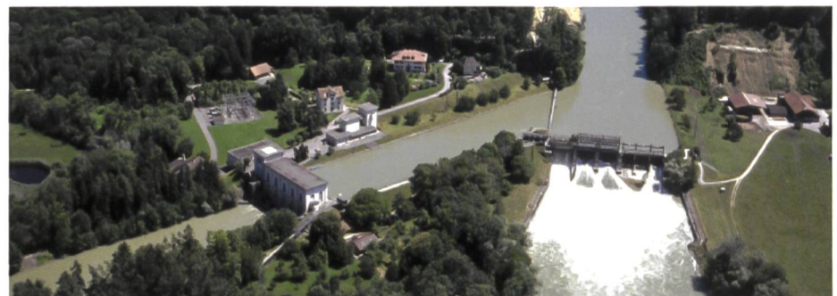
Das bestehend Kraftwerk Hagneck mit Wehr und Zentrale.
