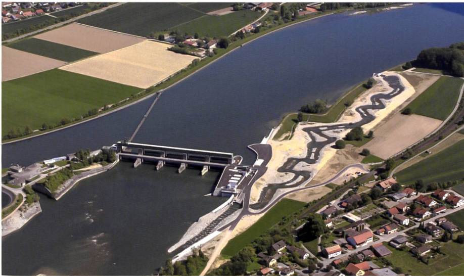
Luftaufnahme des Wehrs Albruck-Dogern mit dem neuen Umgebungsgewässer (Quelle: N. Schneiderhahn, Radag).
