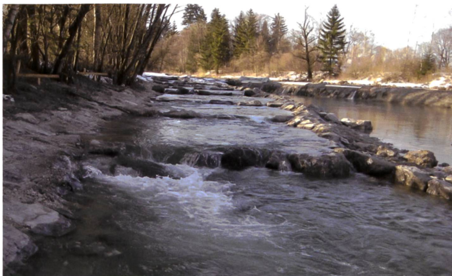
Aufstiegsanlage am Wehr Schönmühl/Loisach (Quelle: E-ON).
