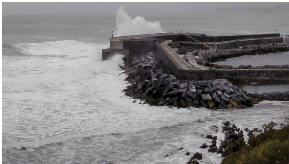
Das Wellenkraftwerk Mutriku (Quelle: Voith).
