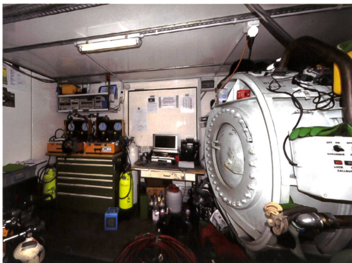
Figure 13. Chambre de pression et poste de régie pour scaphandriers.
