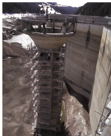
Image 10. Travaux d'échafaudages sur l'évacuateur de crues.
