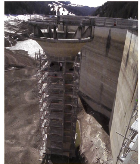
Image 10. Travaux d'échafaudages sur l'évacuateur de crues.
