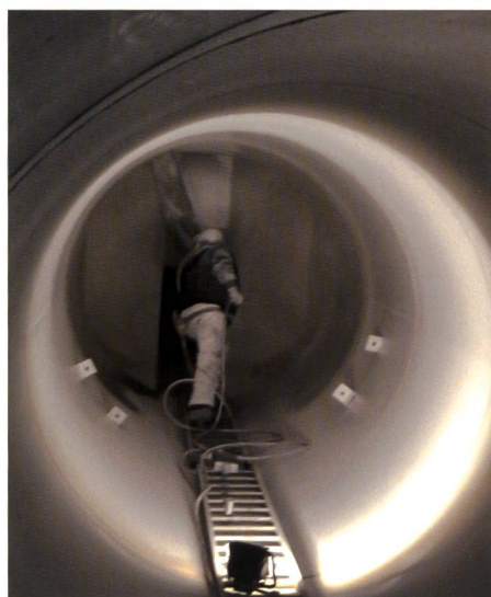
Figure 9. Travaux de protection anticorrosion en dessous des vannes de la purge Sud.
