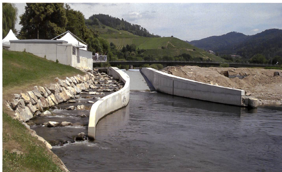
Bild 7. Bewegliches Kraftwerk an der Kinzig bei Gengenbach (D) vom Unterwasser her gesehen: rechts der Trog mit dem Krafthausgehäuse, links die Fischaufstiegshilfe in Form eines Rauhrinne-Beckenpasses.
