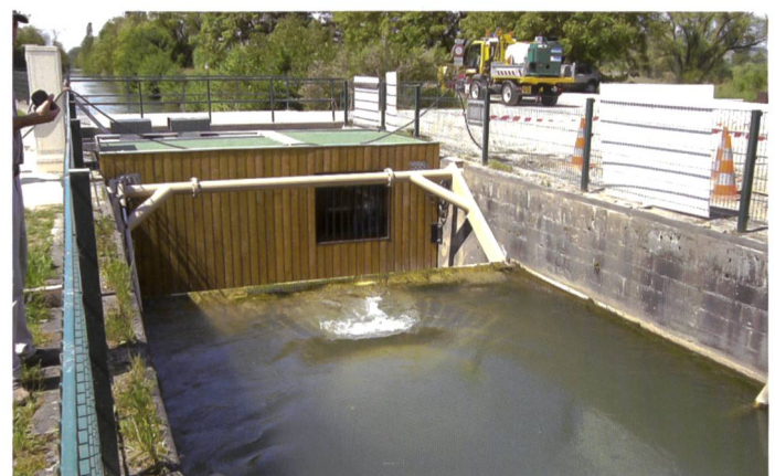
Bild 4. Ansicht des VLH-Konzepts an der Schleuse Nr. 2, Huningue bei Basel vom Oberwasser her. Von der gesamten Anlage ist nur der Schwenkarm der Maschine (weiss) sowie der Container (braun) mit den Nebenanlagen und Hilfsbetrieben sichtbar (hier direkt über dem Unterwasser und damit unter der Geländeoberfläche aufgestellt, da im Kanal kein Hochwasser zu befürchten ist).
