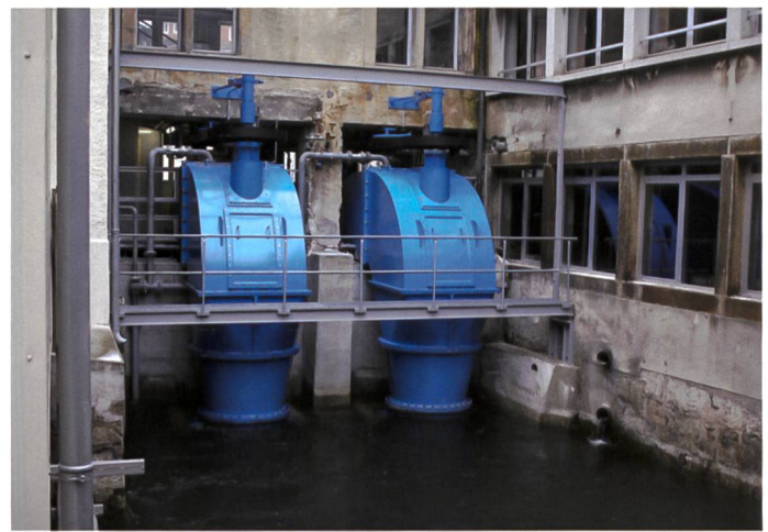
Bild 9. Heberturbinen des MHyLab-Konzepts in Vallorbe.
