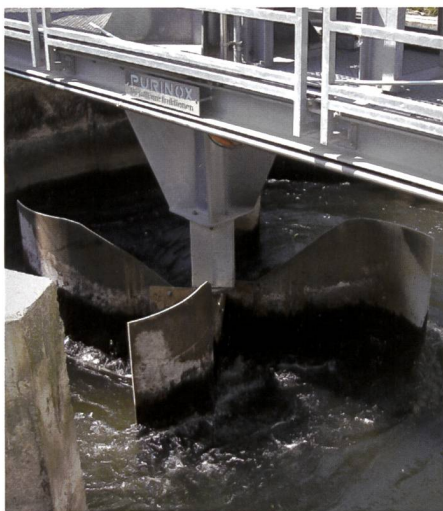
Bild 12. Rotor im Wasserwirbelkraftwerk Schöffland an der Suhre (AG).
