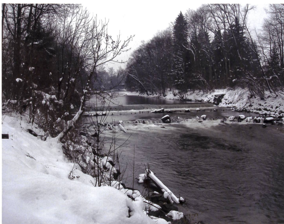
Bild 1. Typische Wehrschwelle in einem Schweizer Mittellandfluss, die für den Erosions- und Grundwasserschutz benötigt wird und ein ungenutztes Wasserkraftpotenzial im Ultraniederdruckbereich unter 3 m Fallhöhe enthält.
