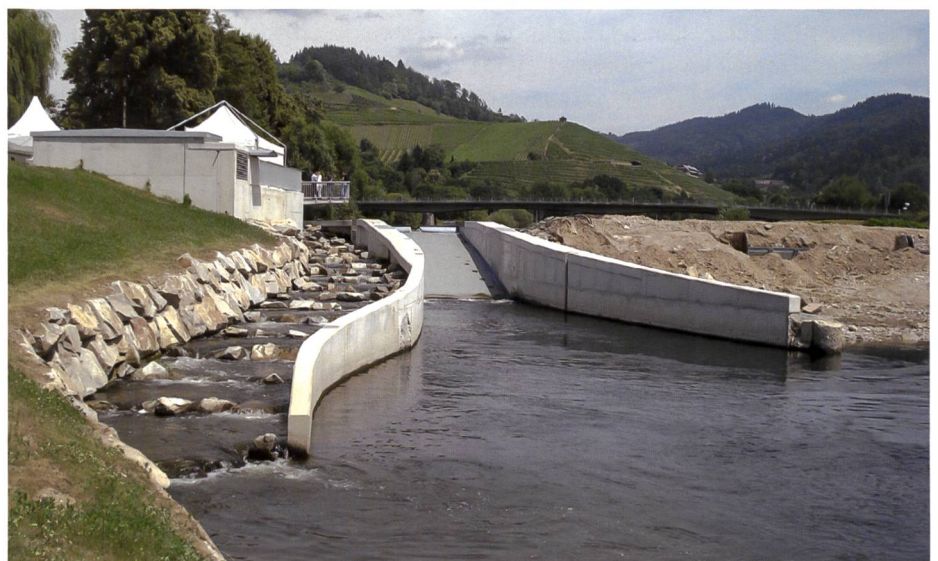
Bild 7. Bewegliches Kraftwerk an der Kinzig bei Gengenbach (D) vom Unterwasser her gesehen: rechts der Trog mit dem Krafthausgehäuse, links die Fischaufstiegshilfe in Form eines Rauherinne-Beckenpasses.
