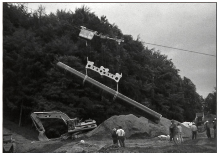
Transport und Versetzen Erdgasleitung, Rohrgewicht 12 Tonnen
