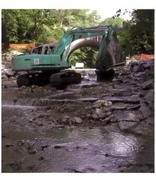
fig. 12. Réalisation d'une rampe à castor dans le cadre d'un aménagement piscicole sur le cours de la Promenthouse. coordonnées: 509460/140750.
