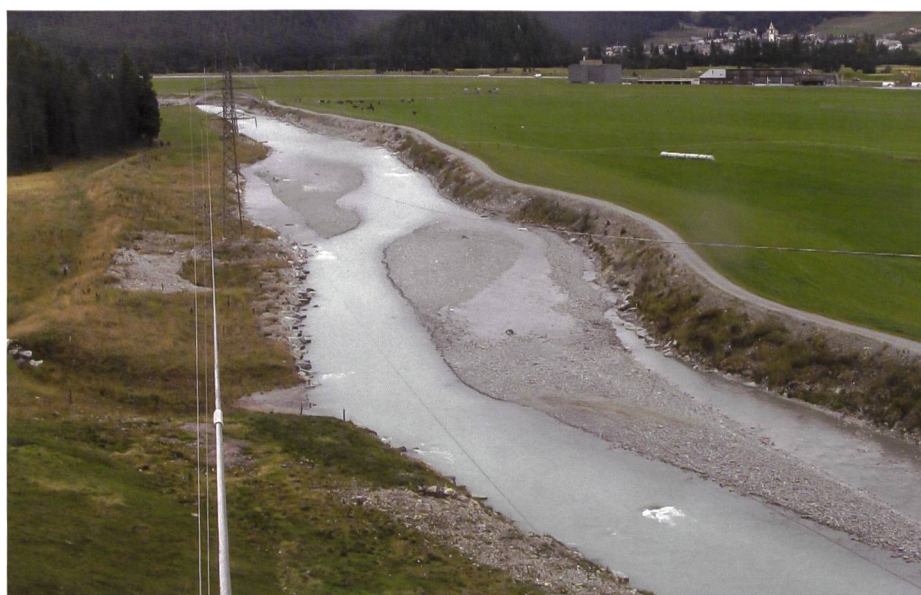
Bild 3. Aufweitung am Flaz bei Samedan [5].
