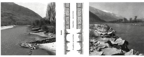
Bild 1. Ausbau der Rhone bei Raron (links) und St. Léonard (rechts) in der 1. und 2. Korrektion: 1. Korrektion mit Dämmen und Buhnen, 2. Korrektion durch Auffüllung der Buhnenfelder und Längsverbau (Quelle: DFI, 1964).
