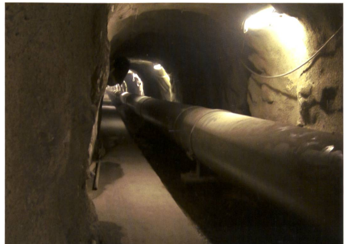
Bild 2. Der 738 Meter lange Stollen mit eingebauter Druckleitung.
