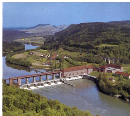
Bild 2. Laufkraftwerke tragen mit rund 30% der installierten Leistung rund 50% der Produktion aus Wasserkraft und liefern vor allem Bandlast. Im Bild das Kraftwerk Eglisau-Glattfelden am Rhein.
