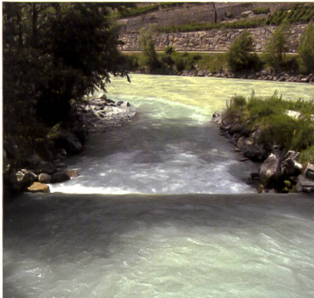
Bild 1. Einmündung der kanalisierten Borge in die Rhone bei Sion VS. Im Vordergrund die Schwelle, welche den Fisch-aufstieg verhindert (Foto EPFL/LCH).
