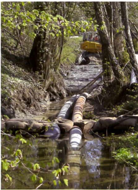
Bild 5. Vermeidung erhöhter Trübung bei Arbeiten an Gewässern.
