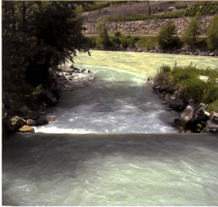
Bild 1. Einmündung der kanalisierten Borghne in die Rhone bei Sion VS. Im Vordergrund die Schwelle, welche den Fischaufstieg verhindert (Foto EPFL/LCH).
