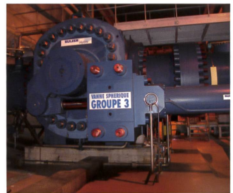
Bild 19. Kugelschieber Bieudron.
