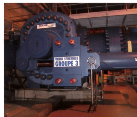
Bild 19. Kugelschieber Bieudron.
