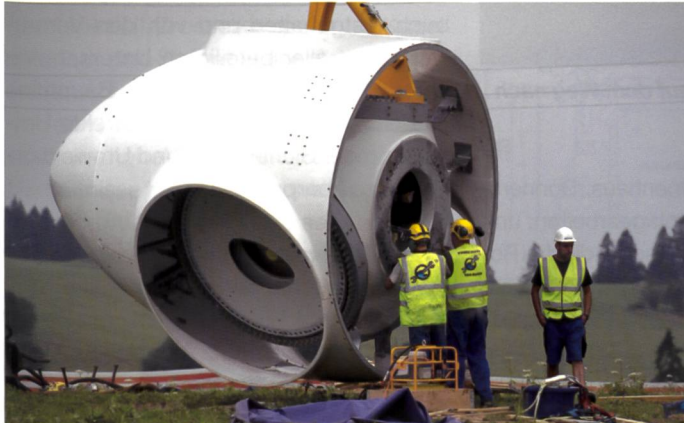
Bild 5. Letzte Vorbereitungen am Hub («die Nase») – bald hievt ihn der Kran in die Höhe.
