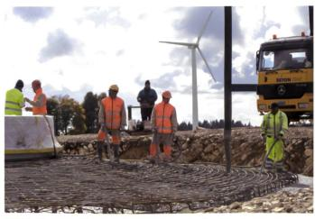
Bild 1. Tausend Tonnen Beton werden in das Fundament gepumpt.
