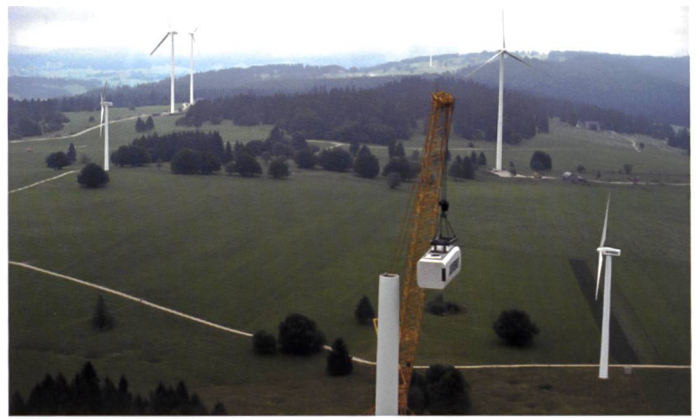
Bild 4. Das Maschinenhaus wird auf 95 Metern Höhe versetzt.
