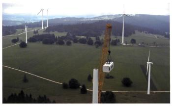
Bild 4. Das Maschinenhaus wird auf 95 Metern Höhe versetzt.
