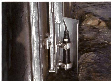
Fig. 2. Sonde de turbidité dans le Rhône.
