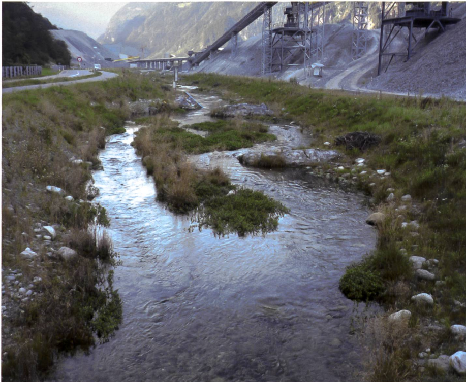
Bild 4. Walenbrunnen Kt. UR: revitalisierte Strecke mit Eintrag von Totholz (Bild C. Rau).
